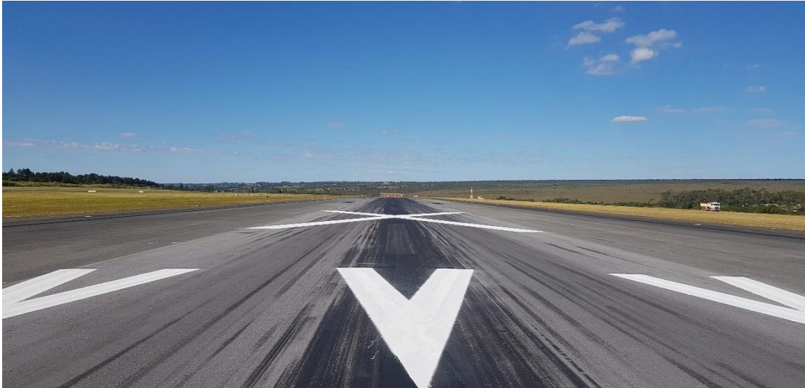
Ilustración 28 - Flechas de umbral desplazado previo al sector de tránsito restringido
