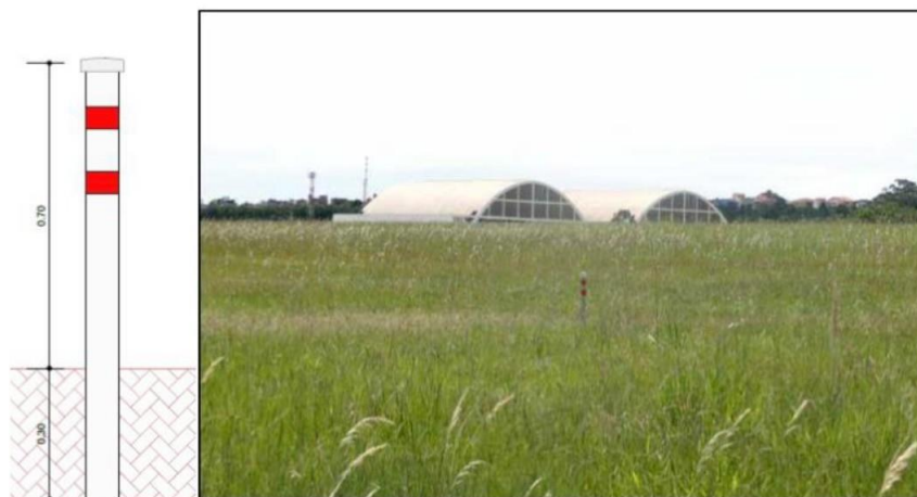
Ilustración 18 – Delimitación de un sector de obra próximo a pista (Fuente: MANUAL para Prevenção de Incursão em Pista no Aeródromo)
