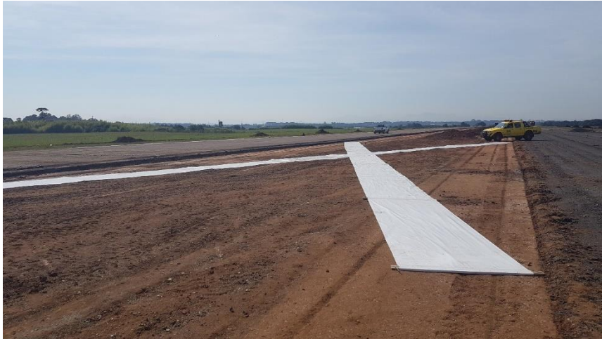
Ilustración 21 – Señal de pista cerrada ejecutada con material plástico.
