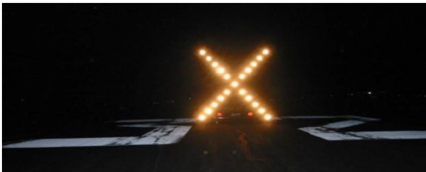
Ilustración 23 - Luz de señalización de pista clausurada (Fuente: AC 153 / 5370-2G)
