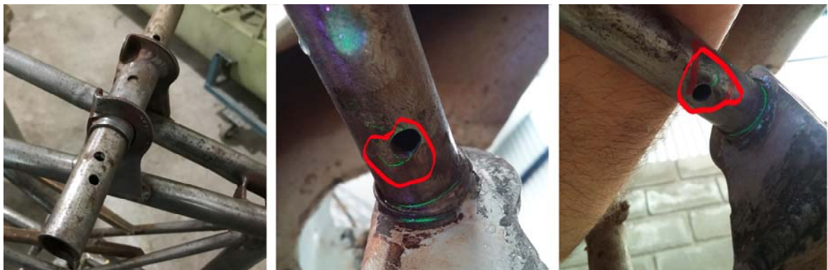
Fig. 5 – Daños detectados en la toma trasera del estabilizador
